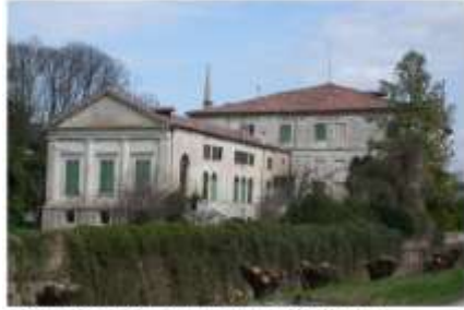
Corpo cinquecentesco addossato al fianco orientale.
